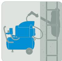
Удаление пыли, продувка отверстий сжатым **воздухом**.
